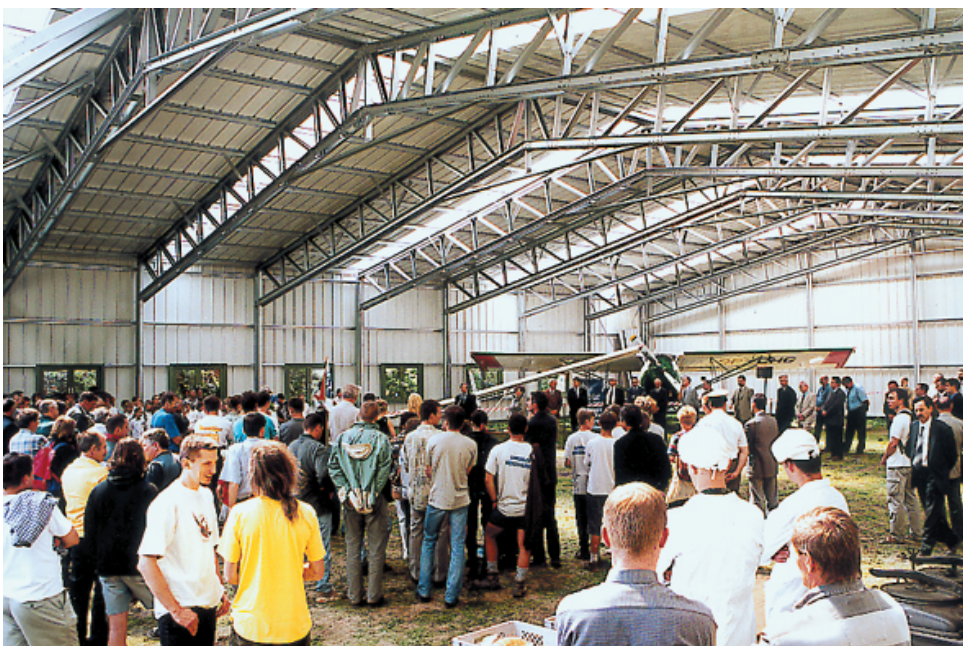
Wnętrze hangaru, który pomieści 12 szybowców lub konstrukcje prototypowych.
