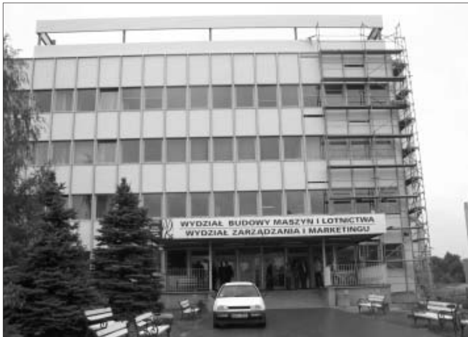
Kompleks budynków L w trakcie termomodernizacji.
