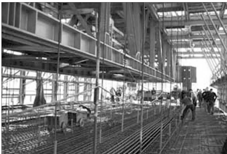
Układanie zbrojenia płyty pomostu.
