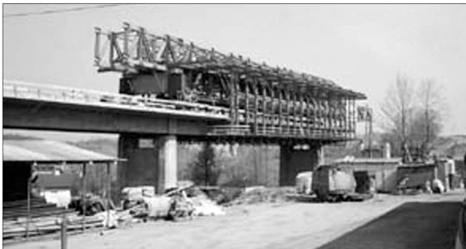
Widok ogólny budowy wiaduktu.
