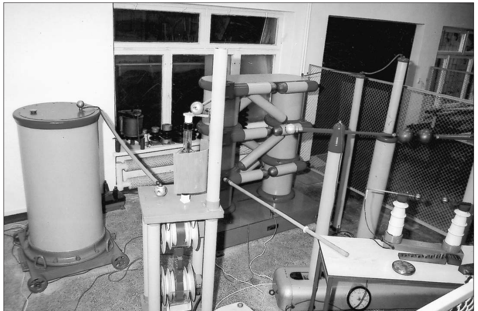
Laboratorium wysokich napięć jako pierwsze zbudowane w Zakładzie (fragment generatora wysokich napięć - stan obecny).
