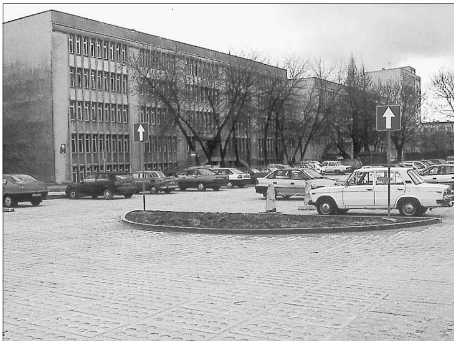
Parking przy ul. W. Pola (zdjęcie wykonane w marcu 2000)
