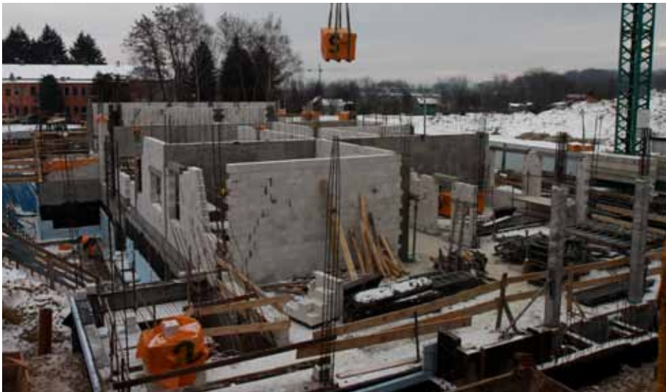
Budowa Zespołu Laboratoriów dla WBMiL.
