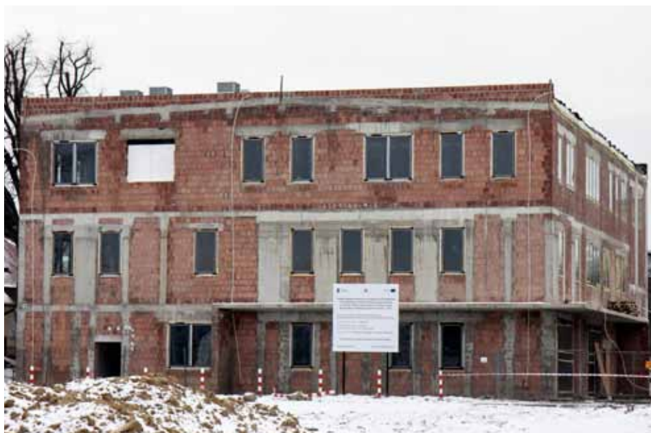
Zespół Laboratoriów dla WBiIŚ w budowie.
