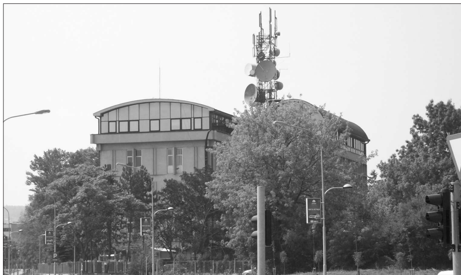
Siedziba operatora komórkowego m:tel, miejsce pracy naszego absolwenta.
